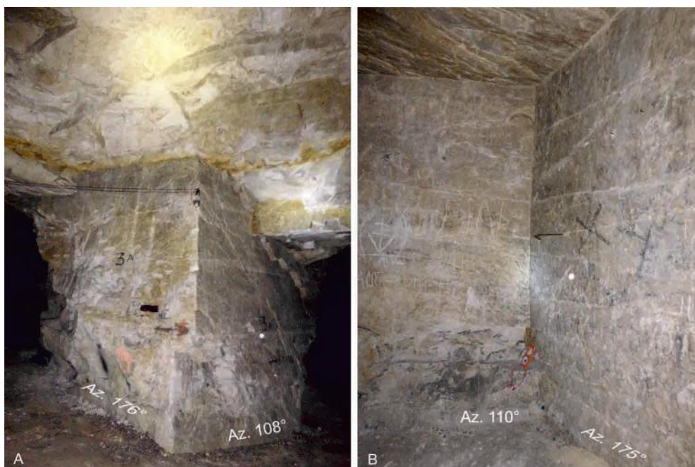
Fig. 22 : Exemples de plans subverticaux parfaitement réguliers dans la carrière Blenheim. A : deux côtés du pilier 3A. A droite : diaclase d'az. 108°, à gauche : plan décrochant d'az. 176° ; B : paroi de la carrière, en face du pilier 3B. A droite : plan décrochant d'az. 175°, à gauche : diaclase d'az. 110° (voir localisation Fig. 21).
