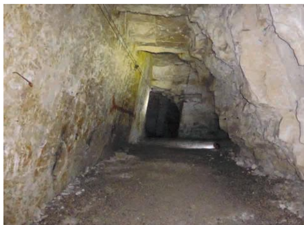
Fig. 23 : Exemple d'un plan décrochant N170°-80°E formant toute la paroi est (à gauche) de la carrière Blenheim (voir localisation Fig. 21).
