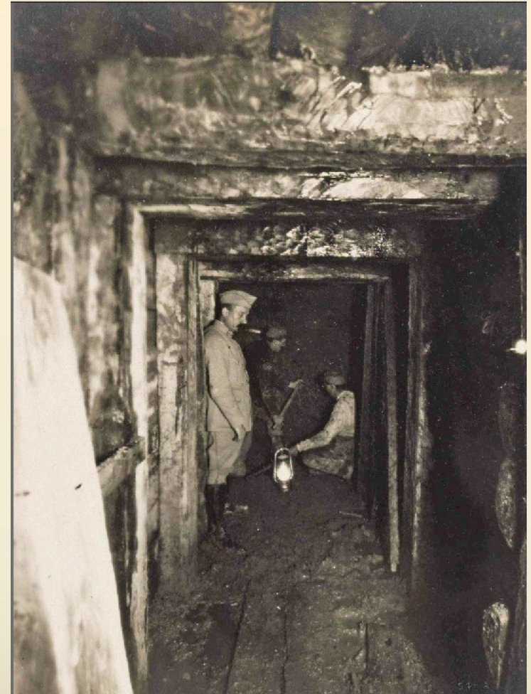
Etayage d'un abri souterrain à Damloup (Meuse), janvier 1916.
