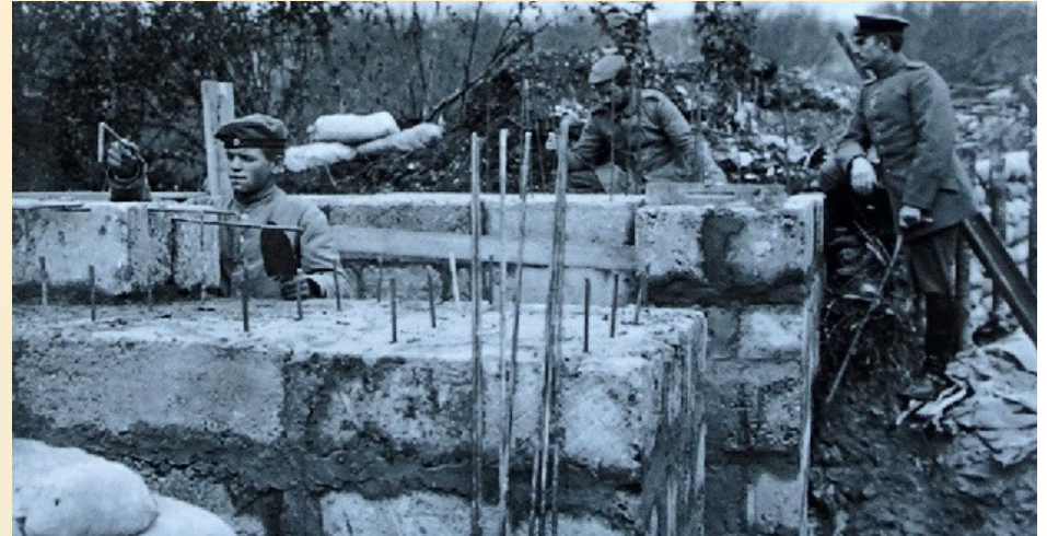
Construction d'un abri de mitrailleuses dans le saillant de Saint-Mihiel (Coll. G. Jacquinet)
