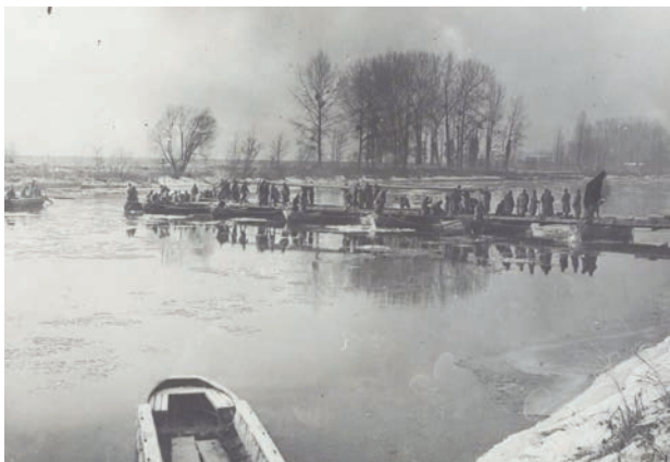
Fig. 9 : Précy-sur-Oise. 3 février 1917. Établissement d'un pont de bateaux (coll. La Contemporaine VAL 279/195). Une unité du Génie aménage le pont, visité par une délégation d'officiers alliés, dont des britanniques et des italiens.
