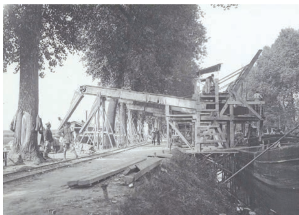
Fig. 11 : Verberie. Juillet 1917. Service routier, transbordeur Dessoliers pour la manutention des pierres (coll. La Contemporaine VAL 281/173). Arrivée, par péniches, des pierres près de leur lieu d'utilisation (Soissons) pour constituer un macadam avant d'être mises dans des wagons circulant sur des voies normales ou étroites (0,60 m).
