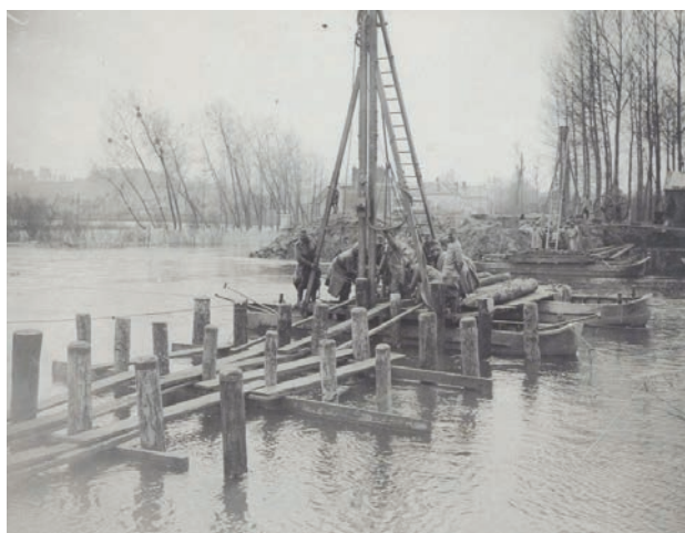
Fig. 16 : Sempigny. 7 avril 1917. Construction d'un pont de bateaux (coll. La Contemporaine VAL 259/048).
