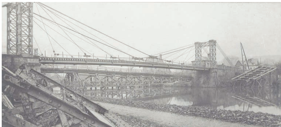
Fig. 18 : Attichy. Avril 1917. Pont suspendu et pont de bois construits par le génie sur l'Aisne ; au premier plan, le pont détruit (coll. La Contemporaine VAL 251/186). Sur les berges, on voit les restes du pont métallique de type Pigeaud (à croisillons métalliques et de portée limitée à 30 m), détruit par l'ennemi. Après avoir établi une passerelle provisoire en bois, le génie a construit un nouveau pont suspendu suivant le procédé Gisclard pour l'édification de ponts suspendus, mis au point par Gaston Leinekugel Le Cocq, ingénieur affecté à la reconstruction à l'arrière.
