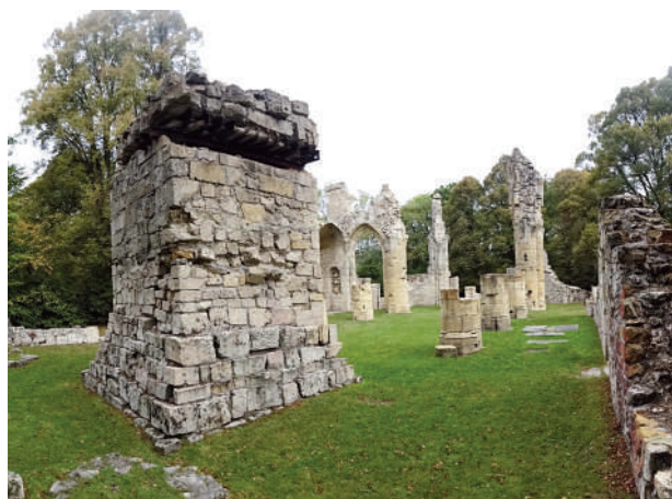
Fig. 9 : Montfaucon-d'Argonne, observatoire allemand construit avec les ruines de l'église. Cliché J.C. Porchier.
